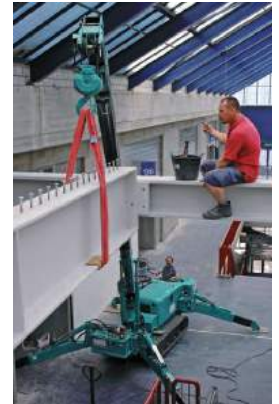
MC305C Stahlbau Bea Halle Messe Bern
